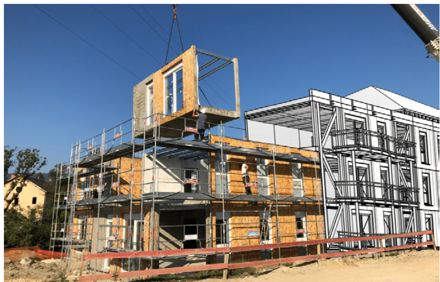
Exemple de module hors site avec voiles béton (Groupe Pelletier)
