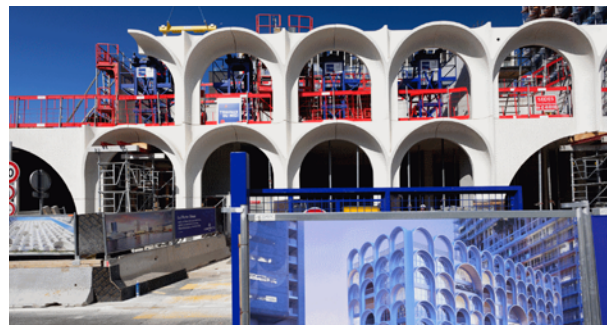
Construction hors-site pour le projet Porte Bleue, à Marseille (La Porte Bleue à Marseille).
