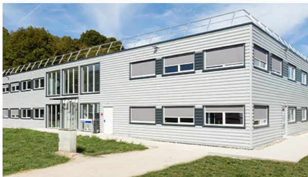
Construction modulaire et assemblage du bâtiment sur site à partir de modules standards (« containers » du type Procontain).
