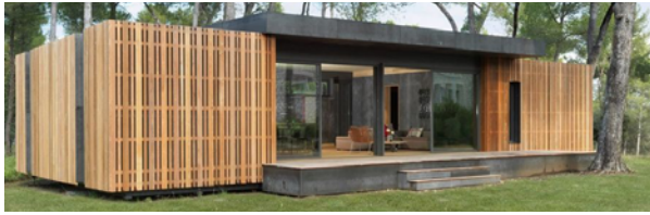
Une maison passive & abordable, 90 % d'économie d'énergie (Une maison d'architecte économique, 2021).
