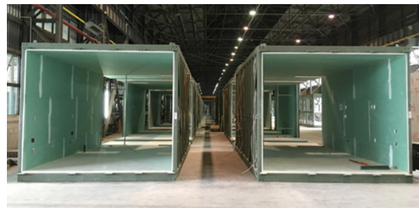
Les structures métalliques des « mods » sont définies avec la plus grande précision. (Christophe Faure, Hors-Site.com )
